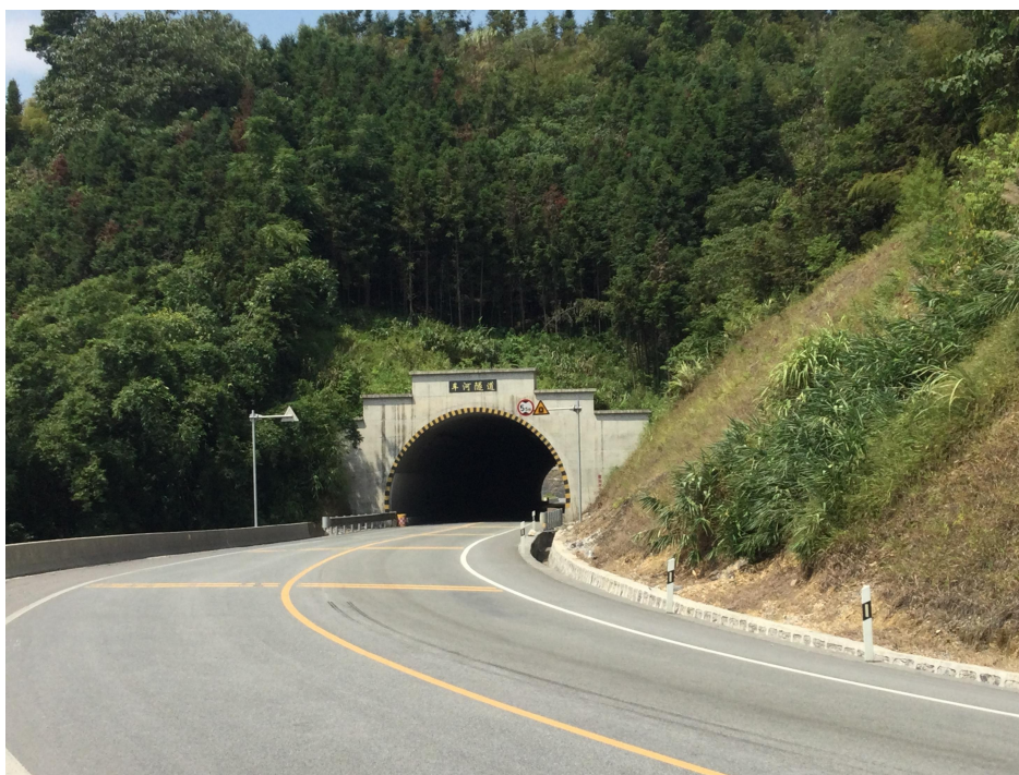
图 1-1 沿线隧道现状图
