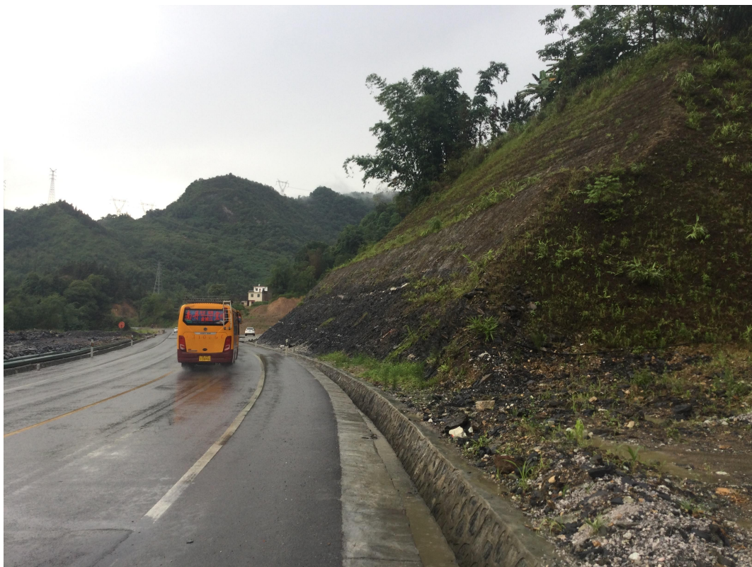
挖方边坡植草防护（三）
