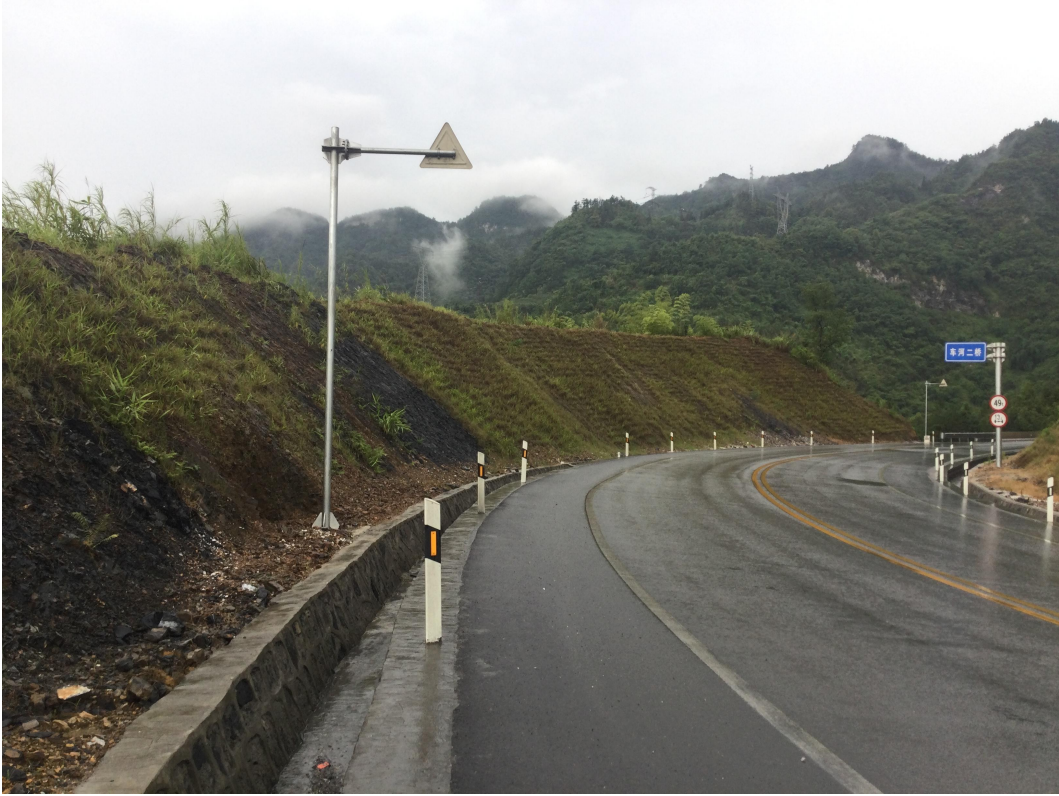
挖方边坡植草防护（一）
