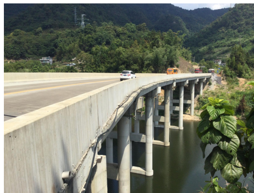
K0+957 灰岭大桥
