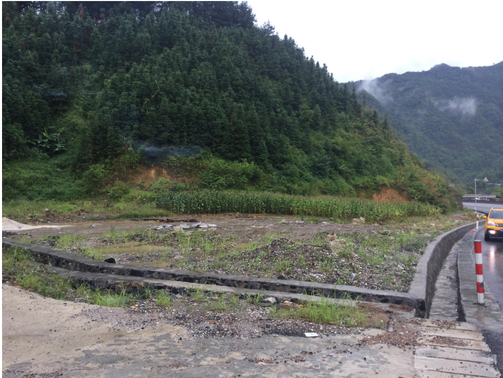
施工生产区（一）
