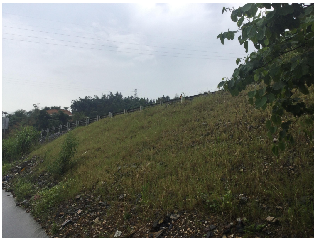
填方边坡植草防护（一）
