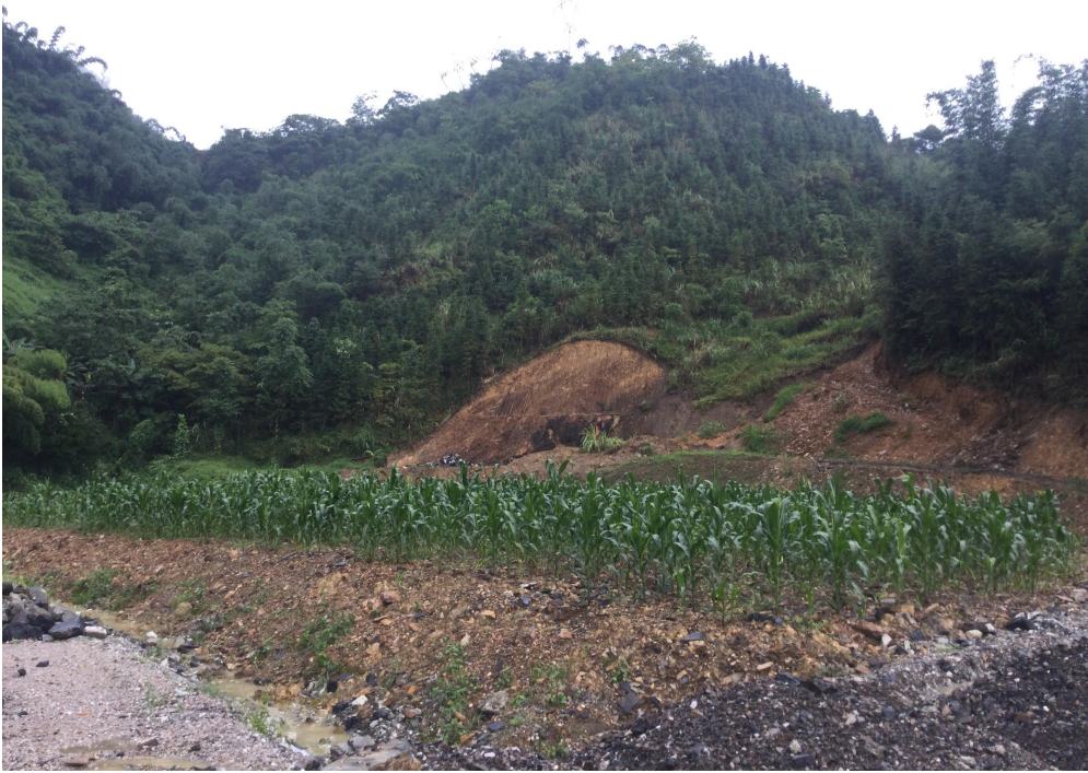
施工生产区（二）
