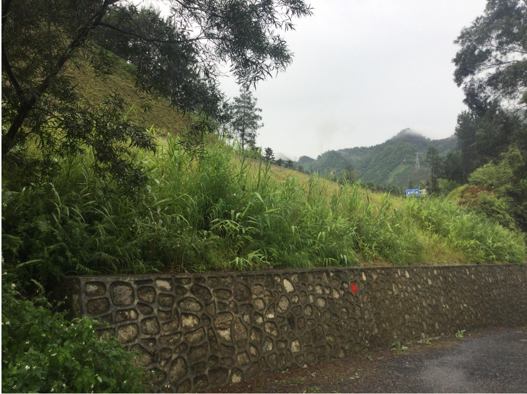
填方边坡植草防护（二）
