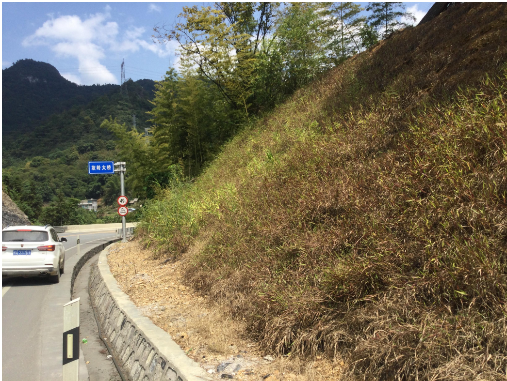
挖方边坡植草防护（二）
